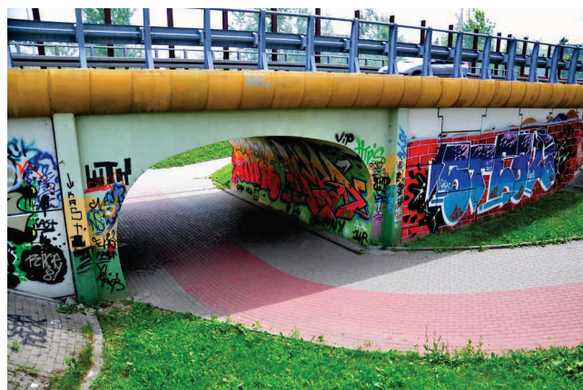
Rysunek 4.5: Ograniczenie widoczności w tunelu między ostrymi zakrętami. Fot: autor
