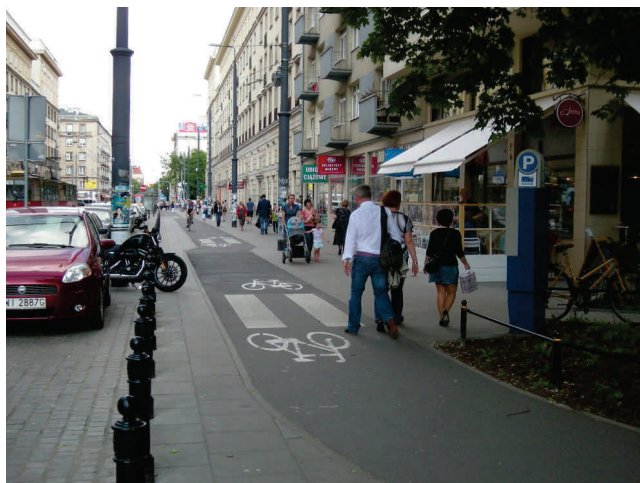
Rysunek 4.6: Niebezpieczne zwężenie chodnika na ul. Nowowiejskiej. Fot: autor
